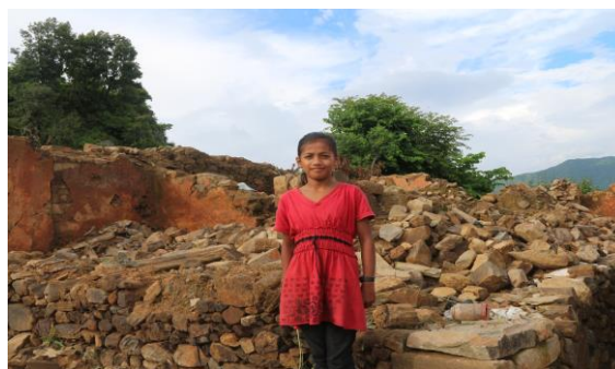
Zerstörtes Wohngebäude einer von uns unterstützten Familie in Amppipal)
