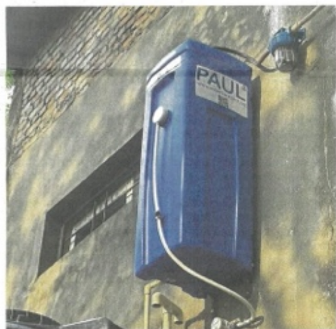
Der von Direkthilfe Nepal finanzierte Trinkwasserfilter konnte Anfang des Jahres dank der logistischen und technischen Ausführung des Vereins „Menschenfreunde“ erfolgreich an der Shree Shiva Sundar Secondary School in Thakurbaba, Bardiya, installiert werden.
